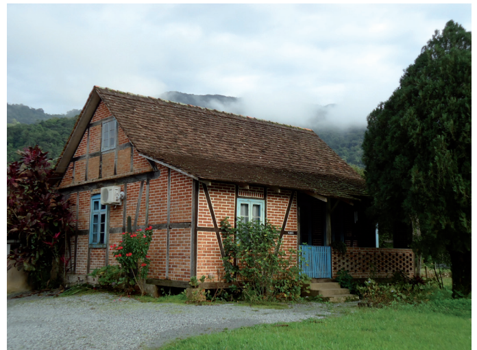
Figura 2. Casa em técnica enxaimel, em Testo Alto. Figure 2. House in "enxaimel" technique in Testo Alto.
